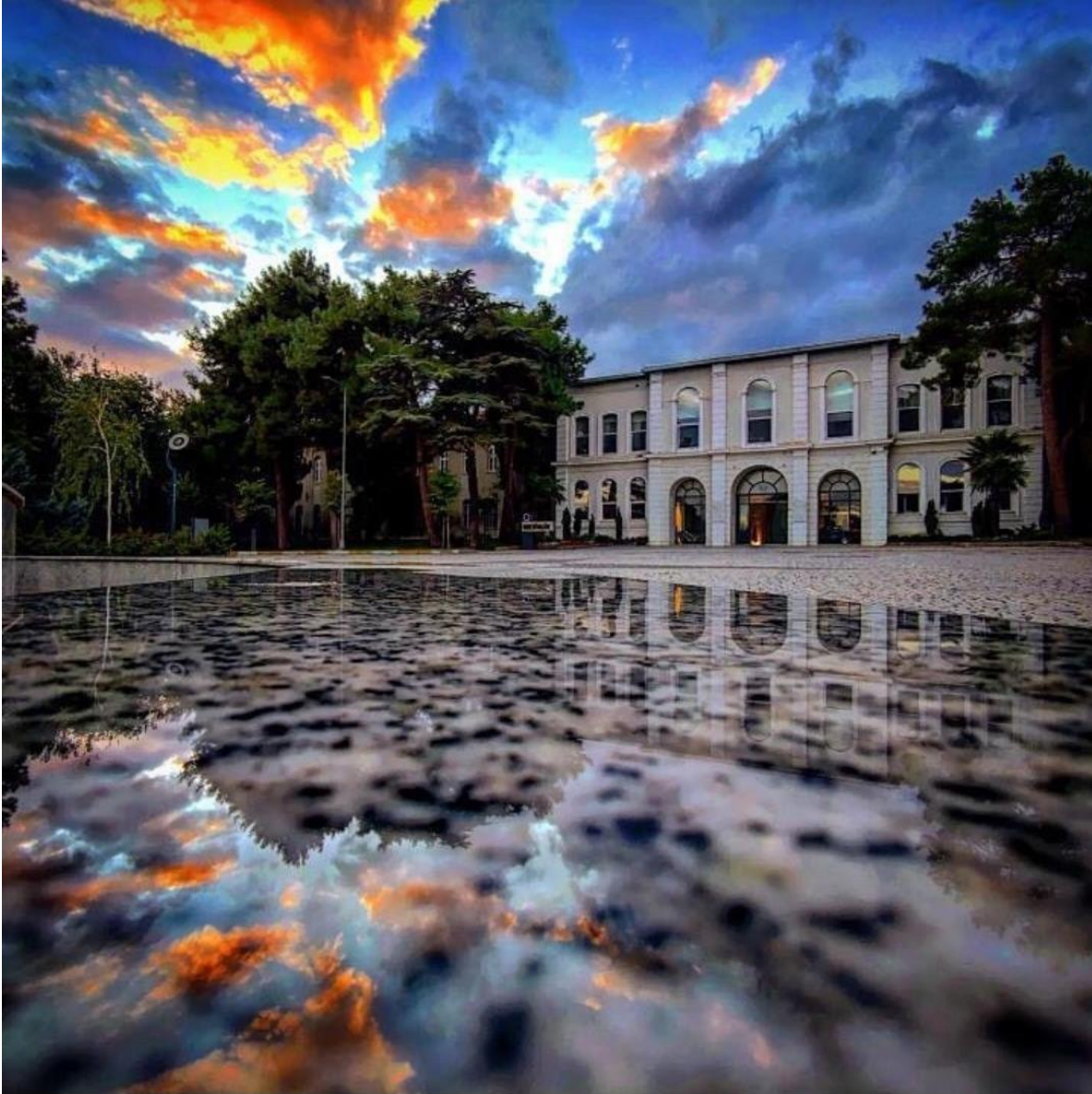
YTÜ Taş Kışla Binası, Davutpaşa Yerleşkesi
