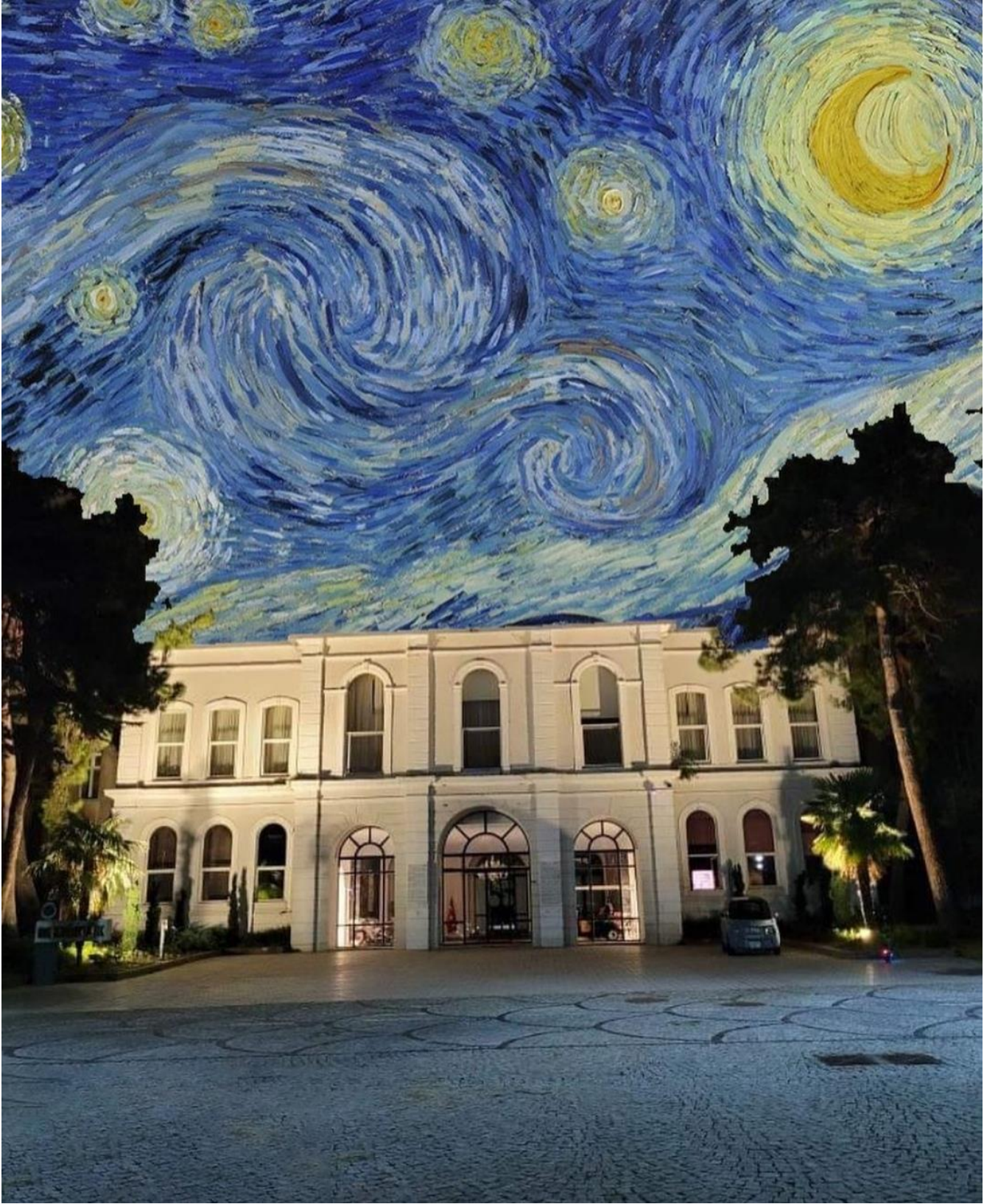
Taş Kışla Binası, Davutpaşa Yerleşkesi
